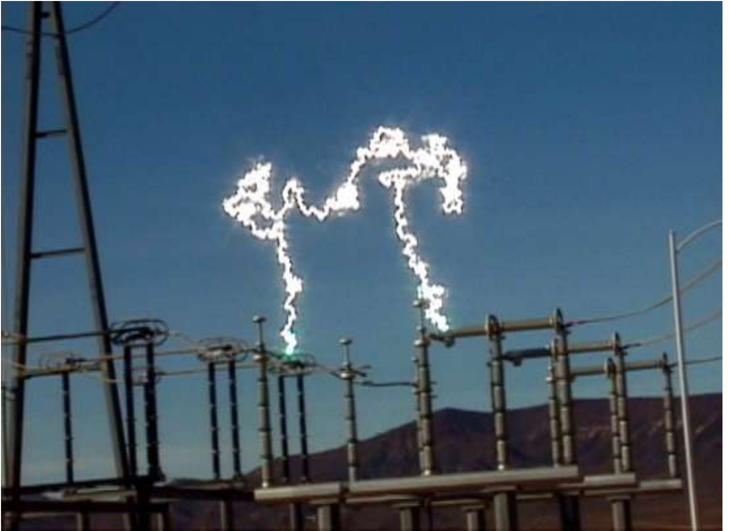
Fig. Arco eléctrico en una subestación de energía.
