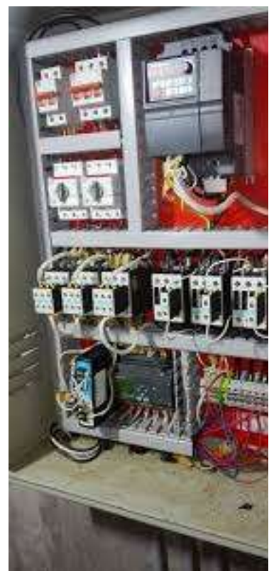
Fig. A) Barra puesta a tierra, B) Interruptor termomagnético general, C) Interruptor diferencial, D) Interruptores termomagnéticos.
