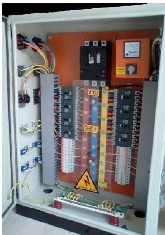
Fig. A) Barra puesta a tierra, B) Interruptor termomagnético general, C) Interruptor diferencial, D) Interruptores termomagnéticos.
