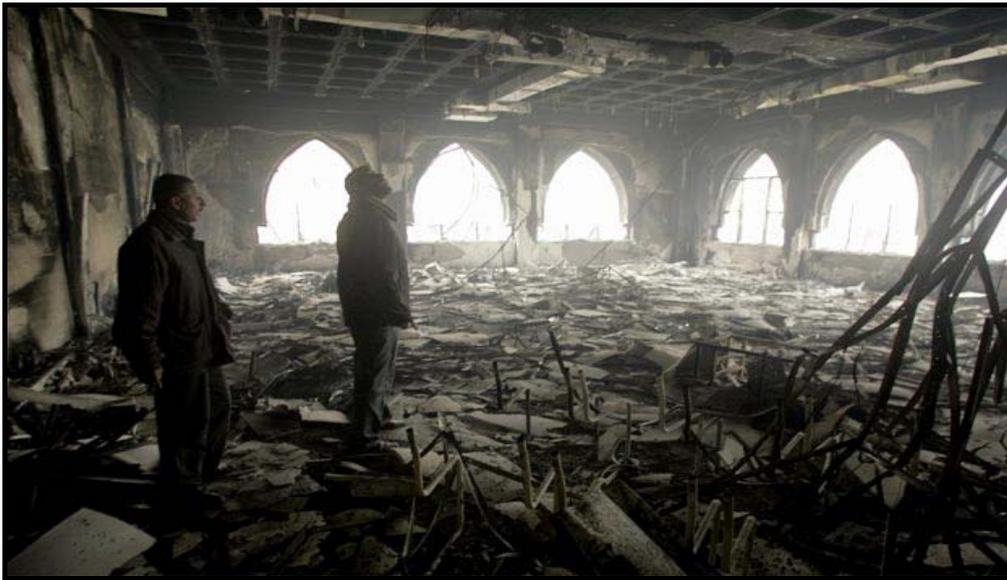
Estructura de hormigón armado afectada por el incendio. Como se observa el mobiliario está totalmente consumido por el fuego y la estructura permanece con relativa resistencia.
