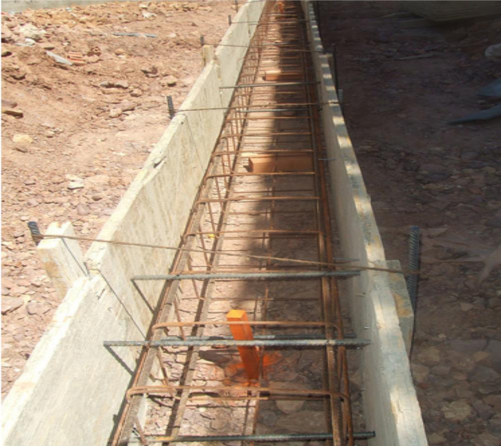
Zapata corrida para muro de carga o muro de contención.
