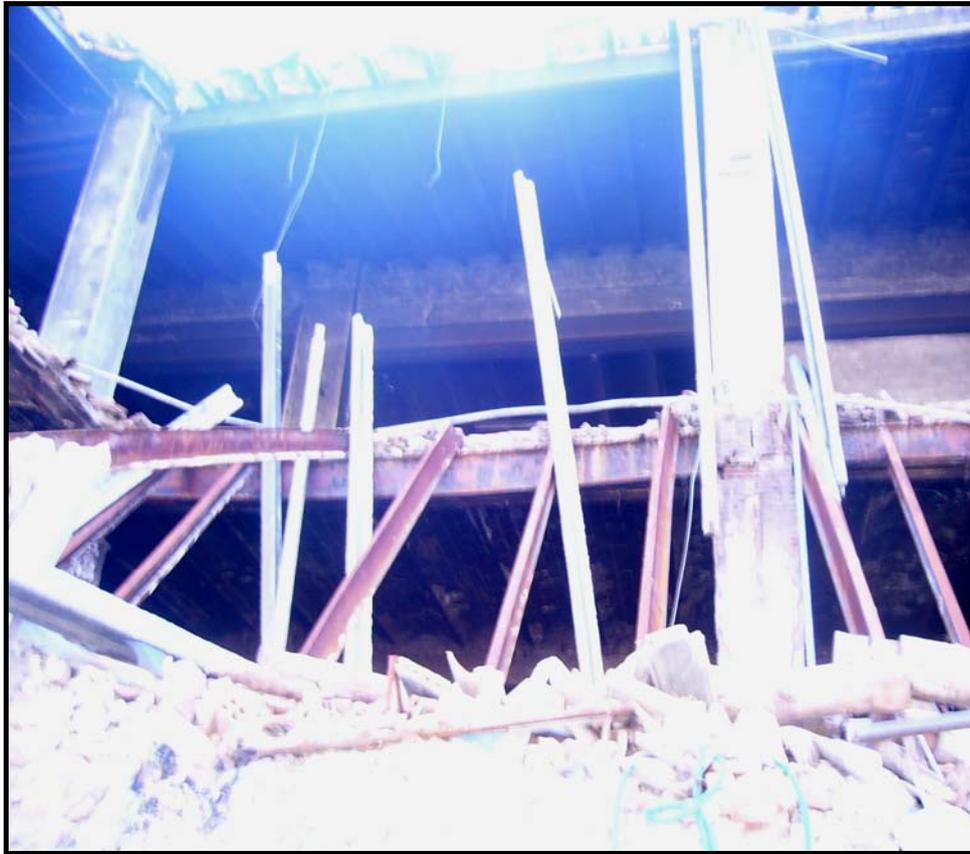
Estructura de pilares, con un forjado metálico, y el superior de hormigón pretensado.
