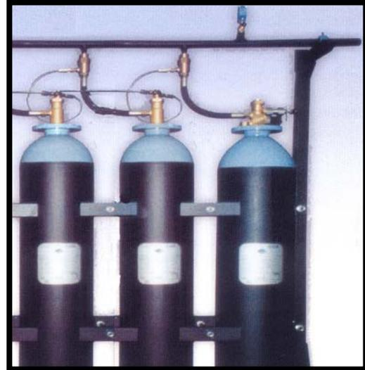
Fig.20 - Sistema fijo de extinción de CO<sub>2</sub>
