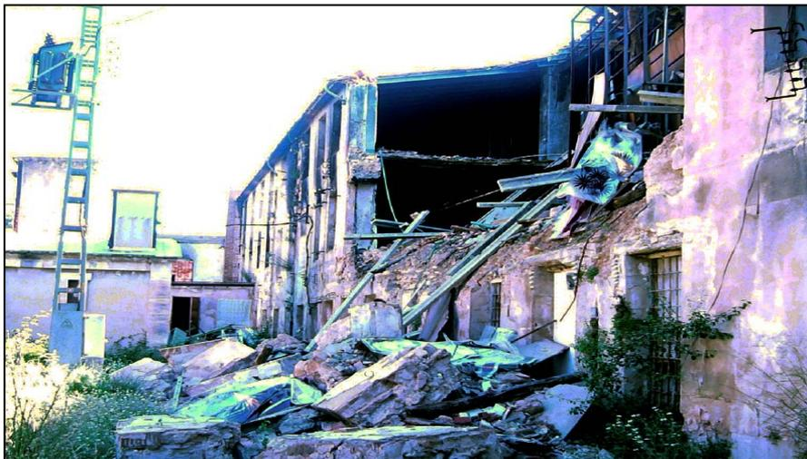
Edificio de muros de carga combinado con pilares y forjados de vigueta metálica y hormigón.
