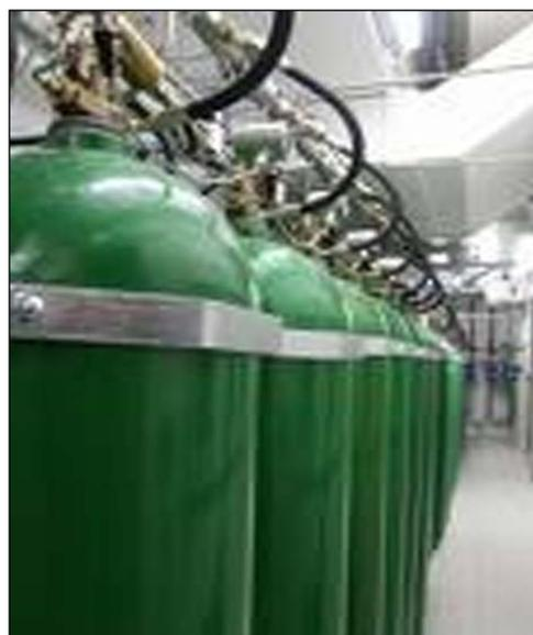
Fig. 27-Batería de botellas de argón.
