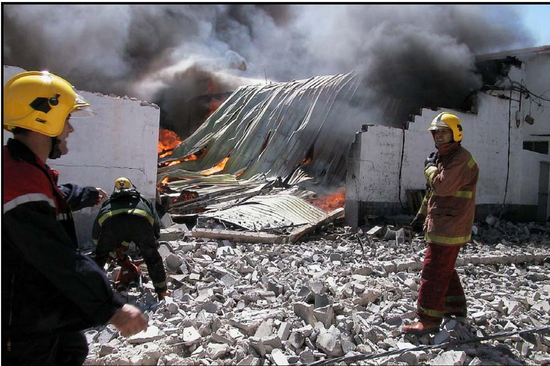
Desplome de muros de fachada con peligro de propagación por radiación.
