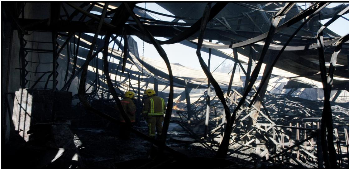
En un incendio real con estructura y cubierta metálica, el edificio puede quedar en estas condiciones, en un tiempo aproximado de entre 10 a 20 minutos desde el comienzo del incendio.
