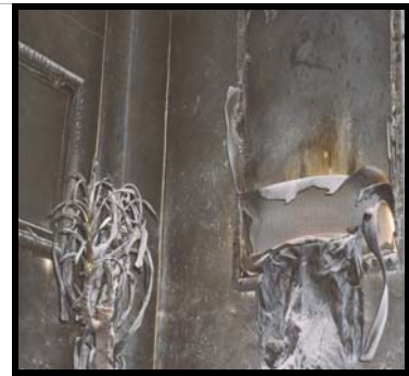
Imagen 3: Después de un flashover
