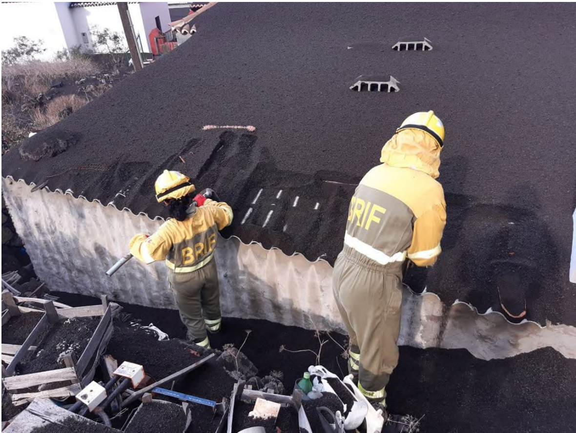
Tareas de limpieza de tejado. La Palma, 24 de septiembre de 2021.
