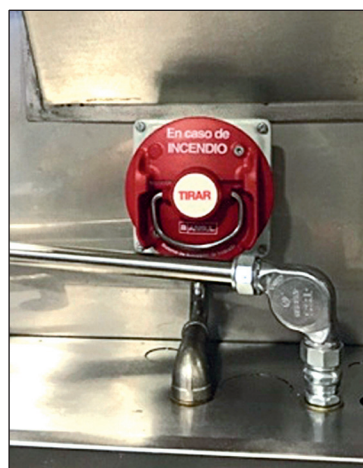
Boquillas de descarga del agente extintor (Izq). Tirador de activación manual (Dcha).
