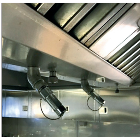
Boquillas de descarga del agente extintor (Izq). Tirador de activación manual (Dcha).
