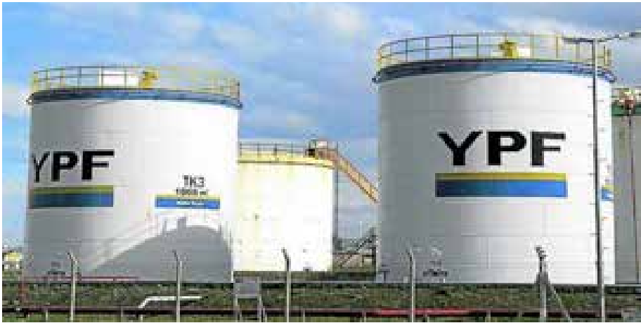
Vertical techo flotante
