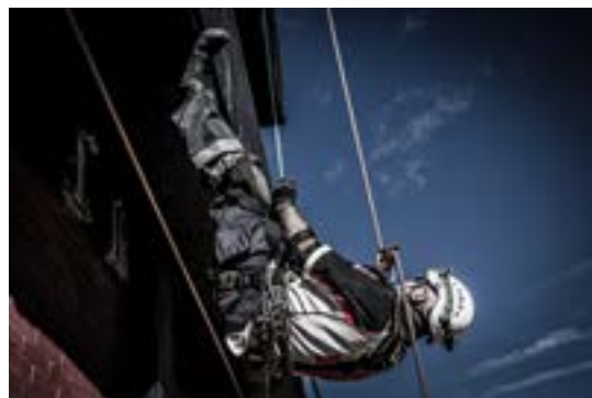
Imagen 5.4. Técnica de vampiro, uso preferentemente en balcones.
