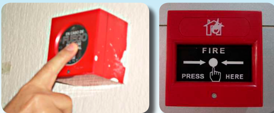
Pulsador para activar "alarma local" y poner en marcha las medidas de emergencia
