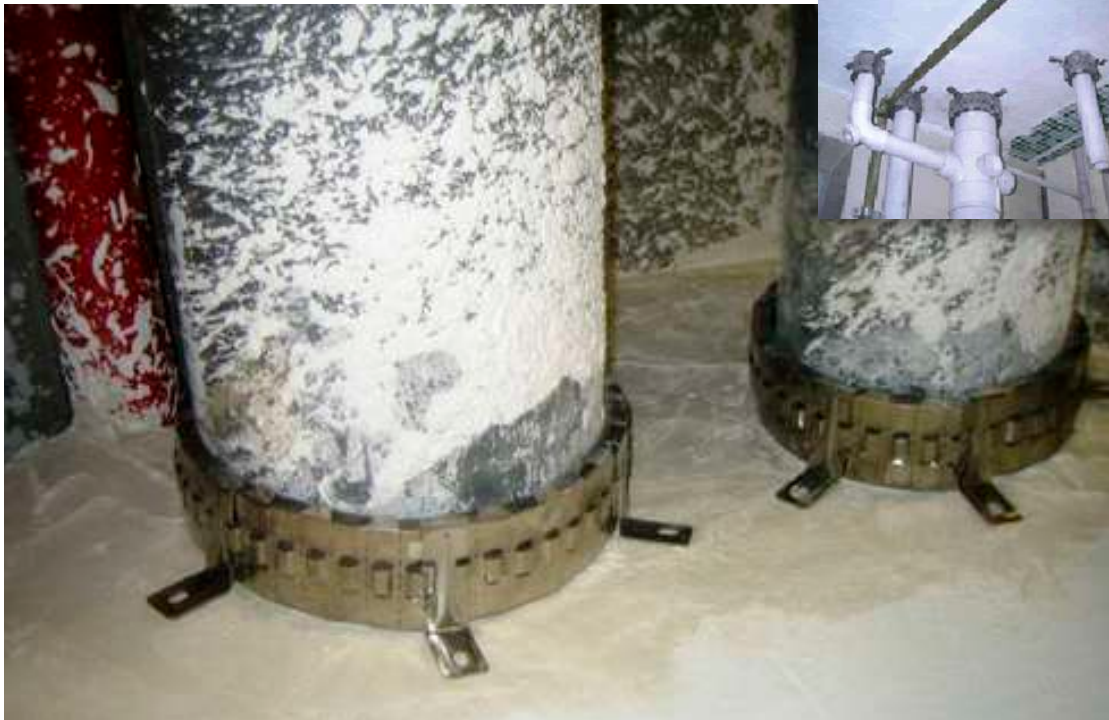
Collarines para sellar hueco de paso de tuberías de PVC a través del forjado
