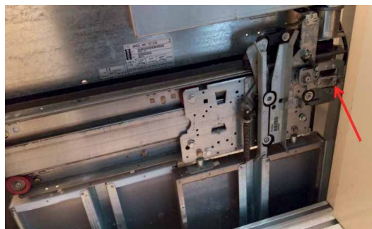
Mecanismo de apertura puerta cabina.
