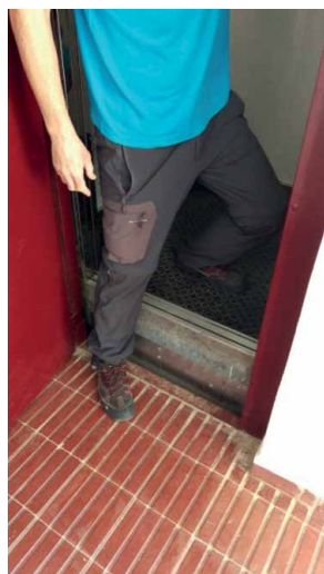
Mínimo desnivel cabina y planta.
