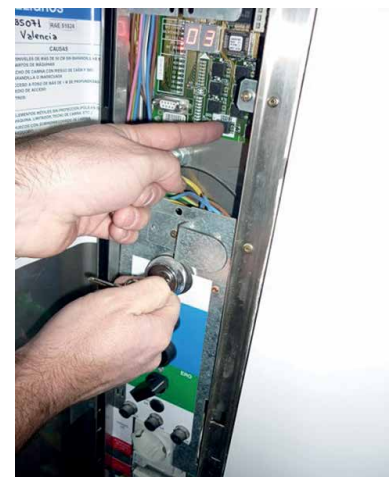
Maniobra manual de emergencia sin sala de máquinas y con botonera.
