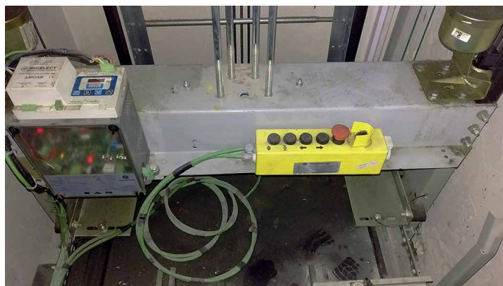
Maniobra de inspección.
