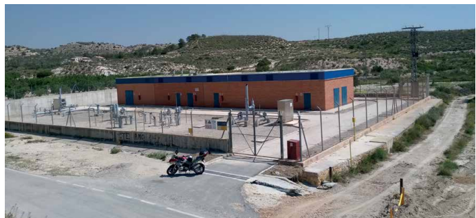
Estación reductora de presión.
