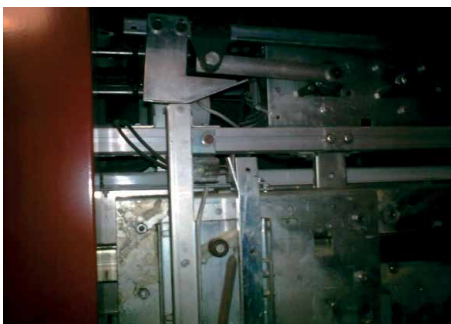
Mecanismo de apertura puerta cabina.
