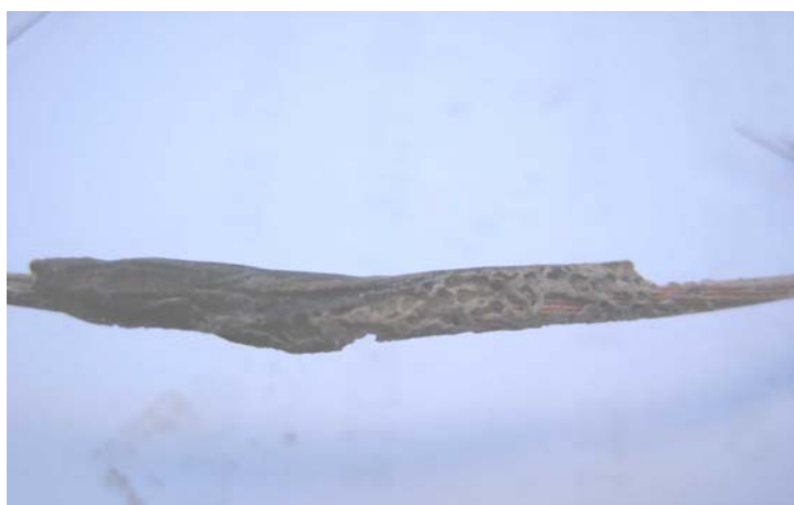
Fotografía 6.1 - Detalle de la destrucción parcial sufrida por el aislamiento tras 5 minutos de exposición al fuego
