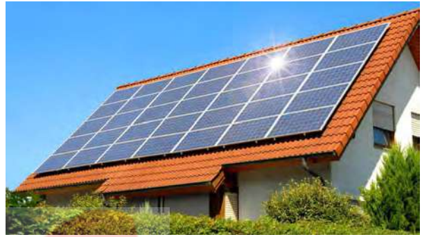
Imagen 41. Placas solares en vivienda unifamiliar
