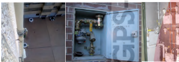
Imagen 9. Puntos de corte dentro del límite de propiedad
