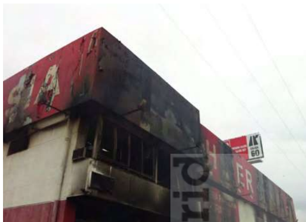
Imagen 28. Línea de 20 kV próxima a nave siniestrada
