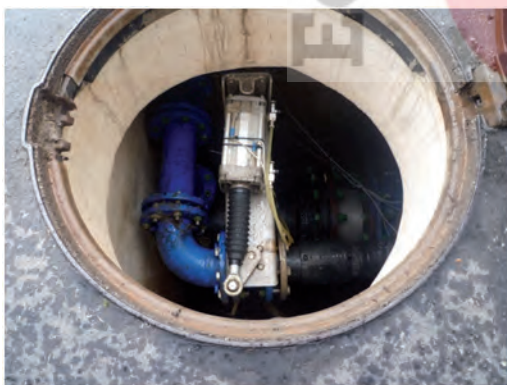
Imagen 1. Registros de ramal y acometida a punto de consumo (Emuasa)
