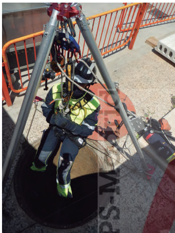
Imagen 14. Anclaje desde trípode para descenso a cota bajo rasante
