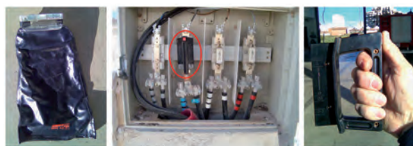
Imagen 6. Manetas portafusibles. Izquierda, con manguito Centro y derecha, sin manguito
