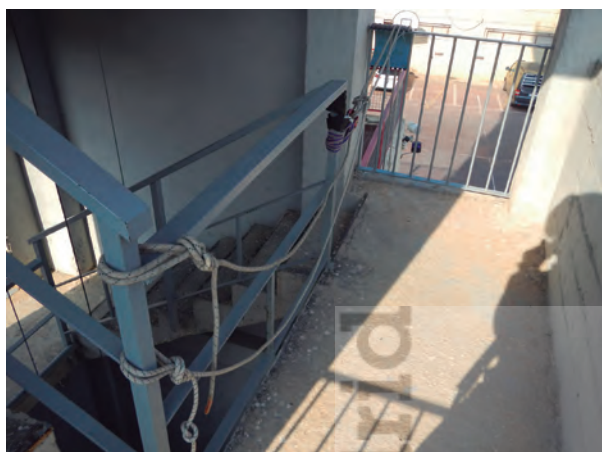
Imagen 10. Anclaje a barandilla de balcón y escalera. Puede observarse que el anclaje principal lleva, además, un doble anclaje de seguro.
