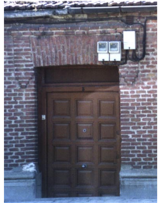
Fig. 4: Caja general de protección en fachada.
