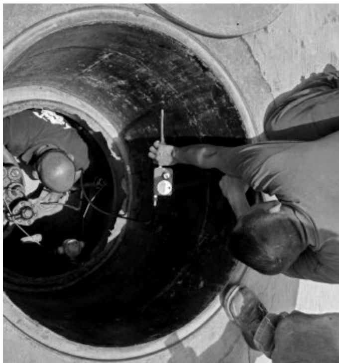
Comprobación ATEX en un pozo de gasolinera.
