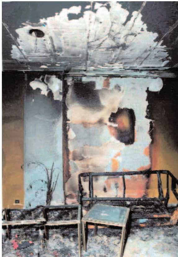
Perspectiva de cono de calor proyectado sobre el paramento vertical, con la base mayor en el techo
