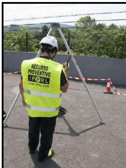
Recurso preventivo vigilando en la boca del recinto confinado
