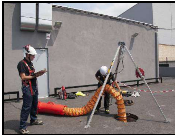
Instalación de un sistema de ventilación
