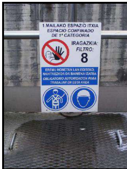
Recinto confinado adecuadamente señalizado
