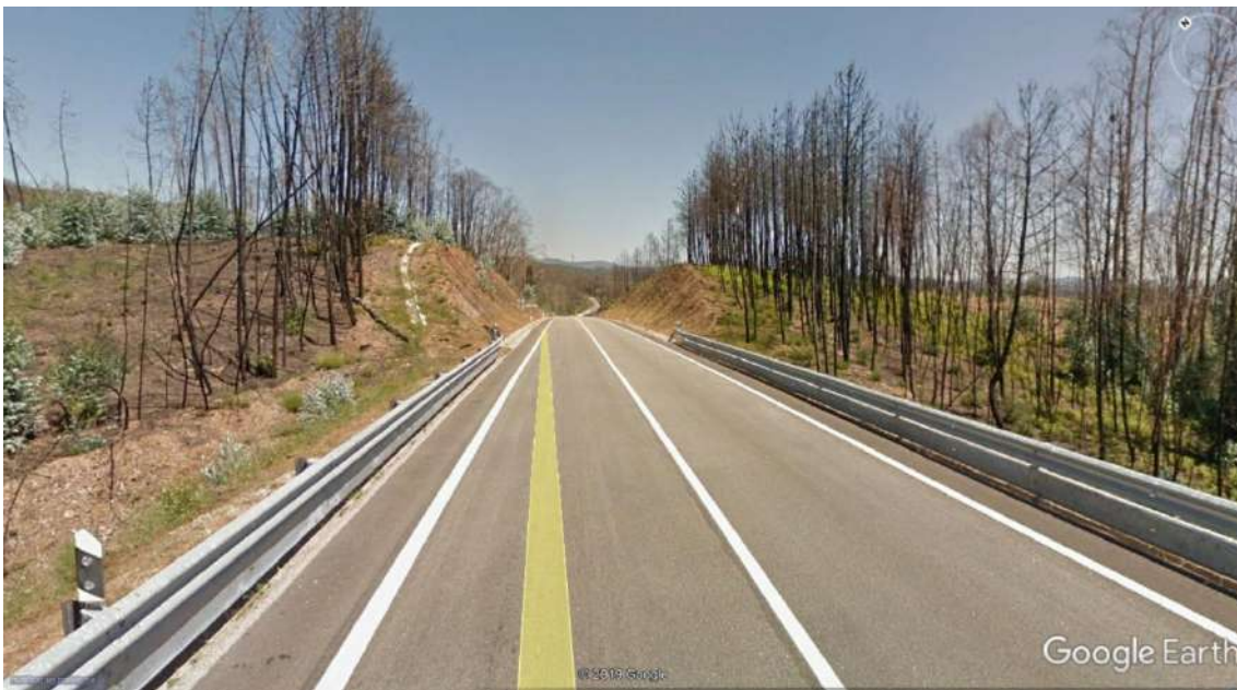
Imagen 21. Carretera NE 236-1 a la altura del paso de la deflagración. Foto actual (2019).
