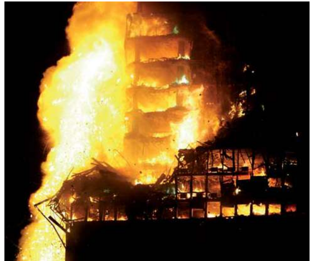
Foto 3.- La estructura de hormigón resiste la acción del fuego.
