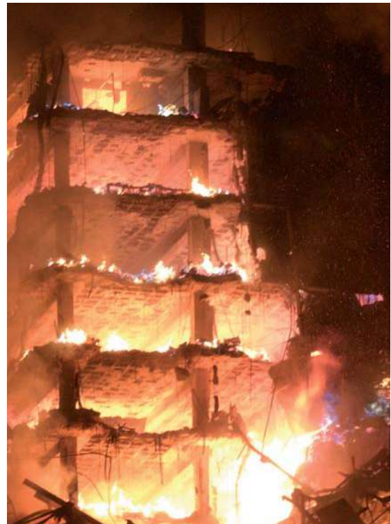
Foto 3.- La estructura de hormigón resiste la acción del fuego.
