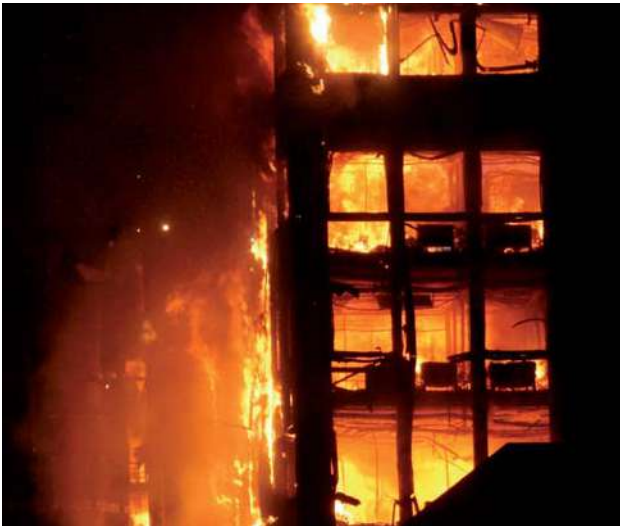
Fotos 1 y 2.- Incendio del Edificio Windsor.
