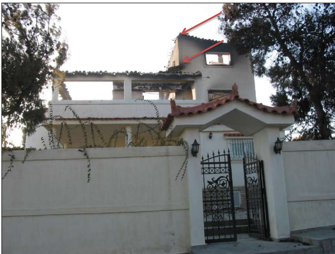
Imagen 62. Se pueden encontrar todavía en muchas construcciones cubiertas que son susceptibles de arder. Grecia 2004 (Fuente: Caballero, D.)
