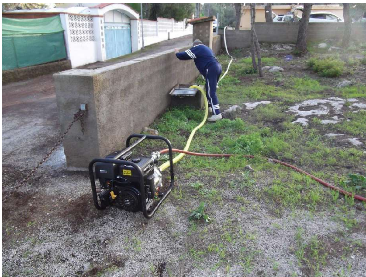
Imagen 79. Motobomba conectada a boca de riego (depósito) en área de Interfaz Urbano-Forestal con tendido de autoprotección de 25mm y punta de lanza. En caso de evacuación queda listo para ser utilizado por los medios. Ejercicios prácticos de despliegue. Urbanización “El Puig Gros”. Carcaixent, Valencia (Fuente: Dalmau-Rovira, F. 2013 )
