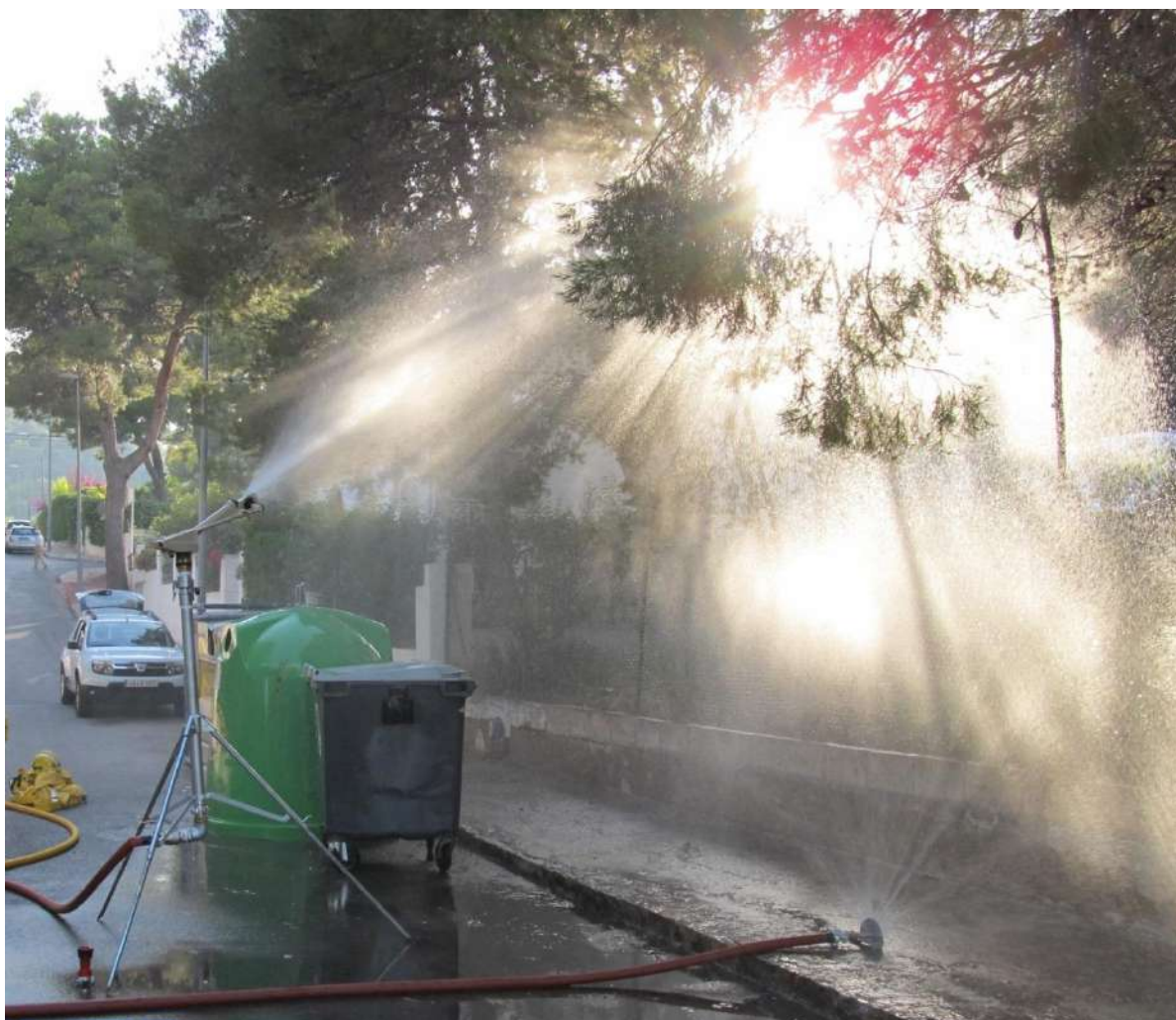
Imagen 104. Maniobra de autoprotección con lanza de autoprotección y monitor conectado el tendido a fuente de agua en área de Interfaz Urbano-Forestal. Fuente: Medi XXI GSA.
