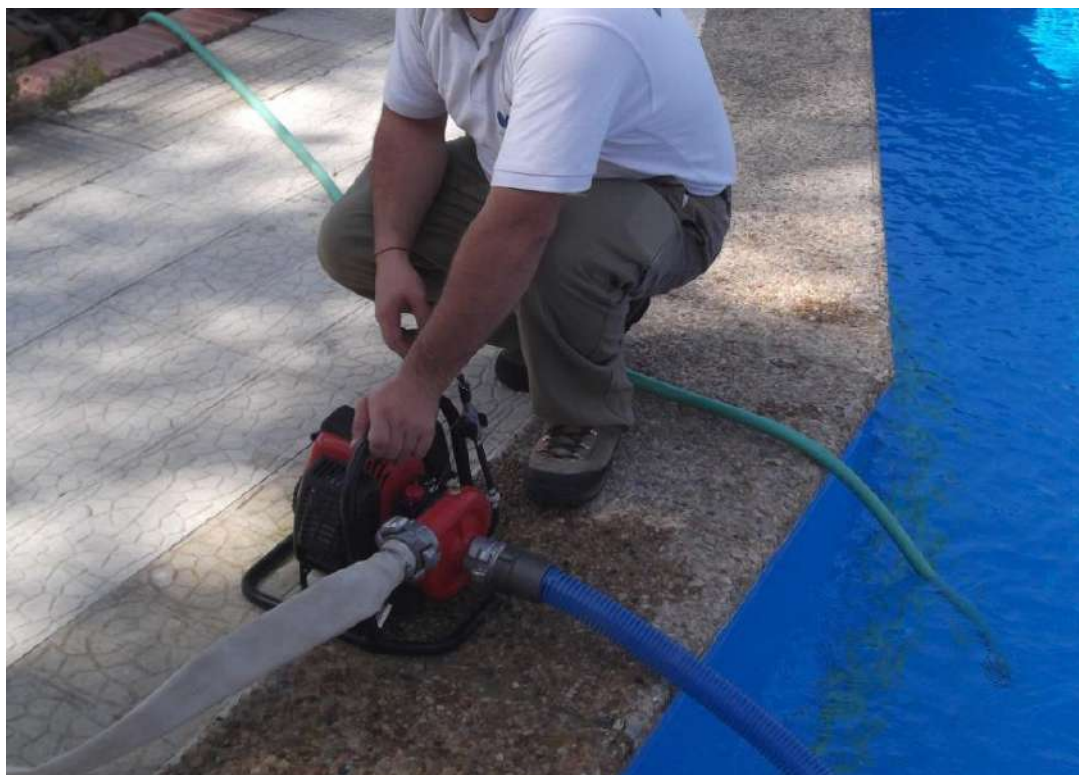
Imagen 8. Instalación de tendido para monitorización de defensa de una vivienda mediante el uso de una motobomba portátil conectada a una piscina (Fuente de Agua No Convencionales; F.A.N.C.) mediante mangote rígido de absorción.
