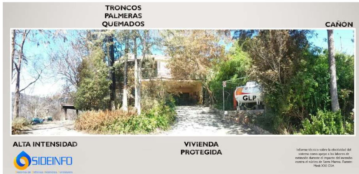
Imagen 86. Sección de impacto contra vivienda dotada de GLP protegida con monitorización SIDEINFO. A la izquierda de la imagen el fuego consume completamente combustible 1HR + 10HR con afección a 100HR y 1000HR (quema en alta intensidad). El depósito no llegó a activar la válvula de alivio de presión al estar siempre dentro de temperatura de seguridad. Informe técnico sobre la efectividad del sistema como apoyo a las labores de extinción durante el impacto del incendio contra el núcleo de Santa Marina.
