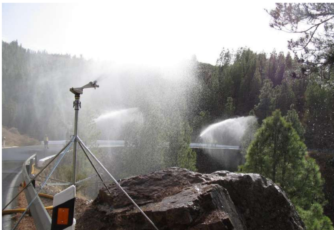
Imagen 98. Despliegue de línea de defensa SIDEINFO para protección de infraestructura vial crítica abastecido con carrusel de vehículos autobomba. Operativo del Cabildo de Gran Canaria. Artenara, 2013 (Fuente: Dalmau Rovira, F.)
