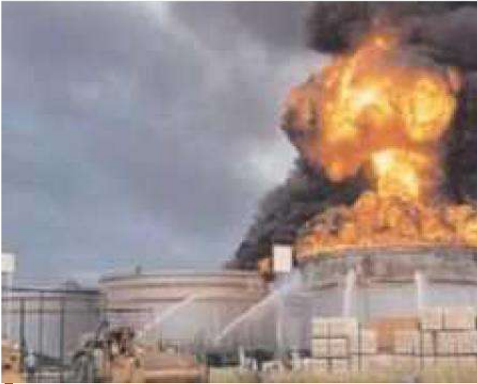
Incendio de un tanque y comienzo de otro contiguo.
