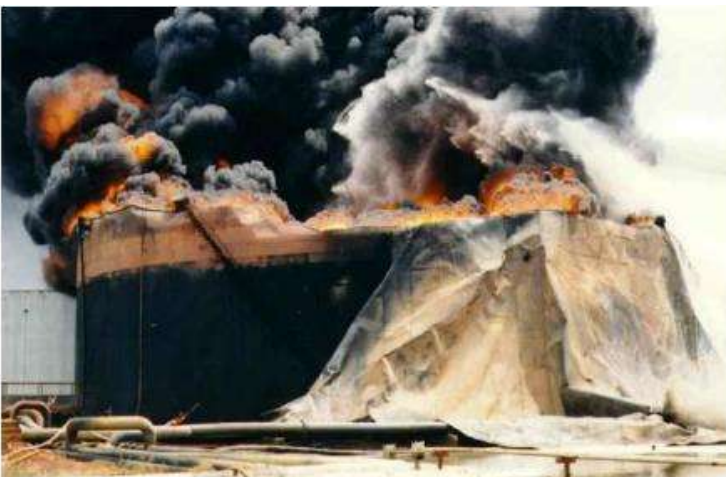
Incendio de un tanque y caída del techo
