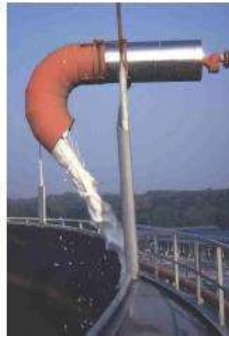
Ejemplos de deflectores en tanques de techo flotante:
