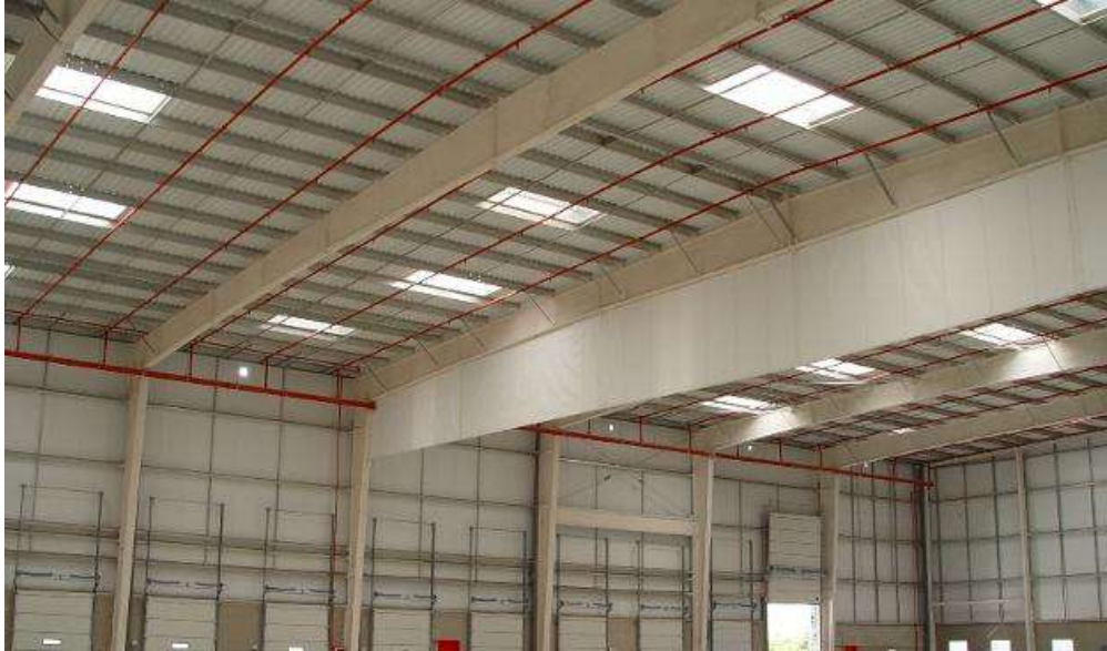
Figura 20.- Barrera de humo fija
