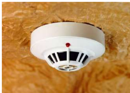
Figura 6. Detector de humo térmico
