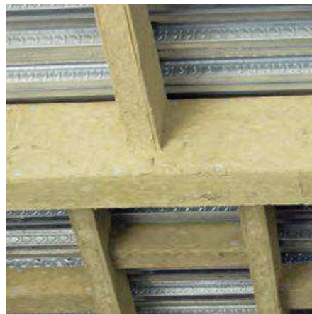
Figura 11.- Viga metálica protegida mediante placas
