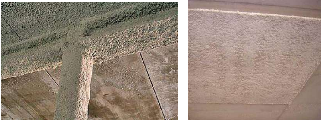
Figura 10. Ejemplo de proyección de mortero en vigas y techos
