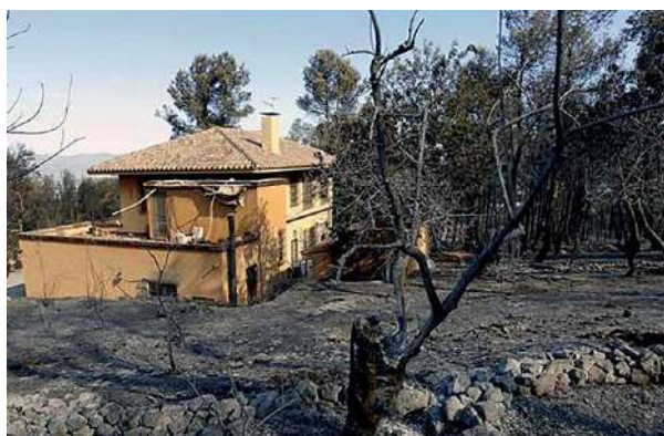
Exteriores de una vivienda en el incendio de Ontinyent 2010. (Fuente. Levante).
