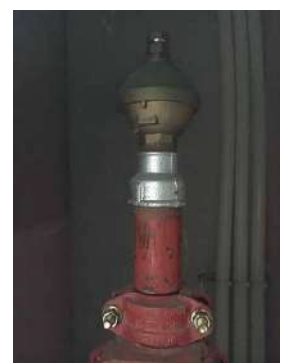
Válvula expansión aire. (Fuente propia).
