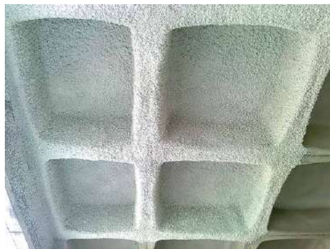
Mortero lana roca proyectado en forjado. (Fuente. Ignífugos Eurofire).
