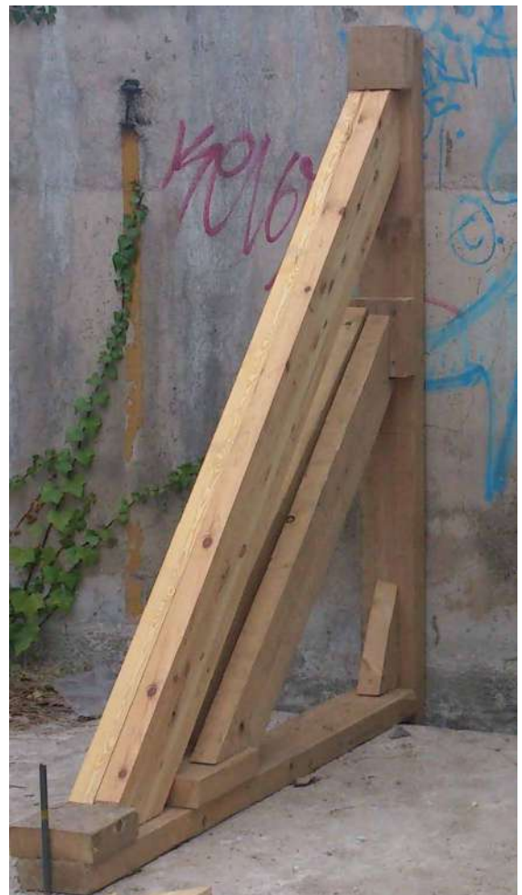
Apeo Inclinado en Paralelo. Autores.
