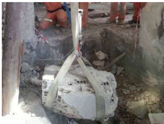
Levantamiento de cargas. (Grupo U.R.E.C., 2017, s.p.)
