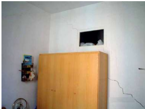
Lesiones de asentamiento de un pilar interior de un pórtico.
