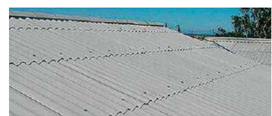
Cubierta fibrocemento (Fuente. Cembrit).
