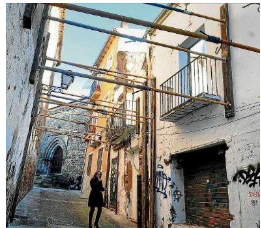
Acodalado de muros. (Fuente. Internet Google).
