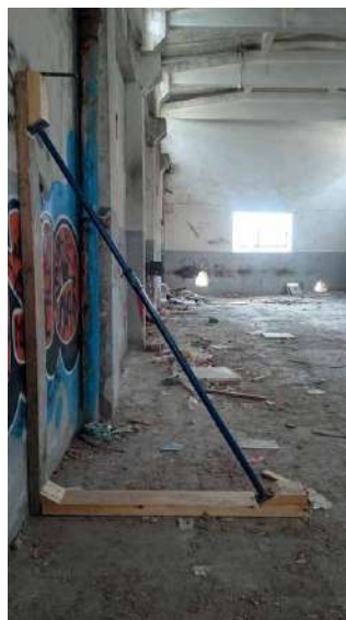
Apeo Inclinado Simple metálico. Autores.
