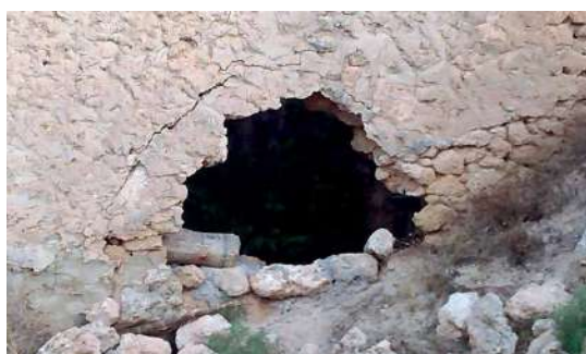
Lesión de asentamiento central de un muro, arcos de descarga.
