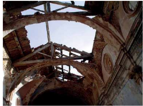
Bóveda tabicada, doble cubierta de nave de iglesia.
