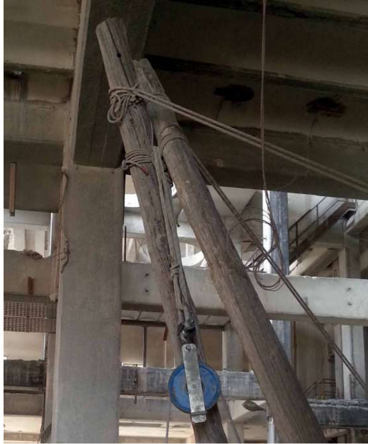
Cabecera cabra ligera. Colocación de polea. (Grupo U.R.E.C., 2017, s.p.)
