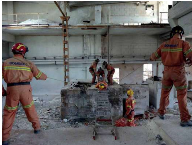
Paso de grieta. (Grupo U.R.E.C., 2017, s.p.)
