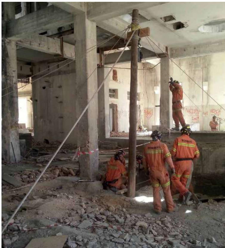
Ejecución de los vientos. (Grupo U.R.E.C., 2017, s.p.)
