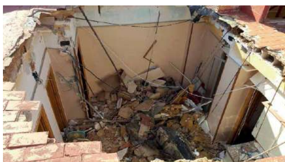
Hundimiento tejado casa unifamiliar sobrecargando forjado y viga lesionada. Se apea de urgencia la viga y forjado con puntales metálicos.
