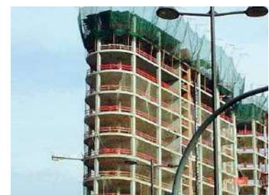
Estructura de pórticos de nudos rígidos.
