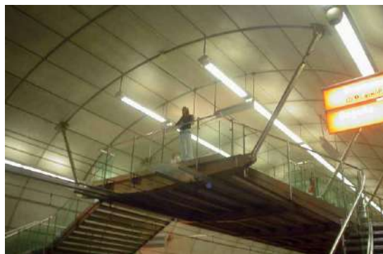
Pasarela del metro de Bilbao suspendida.
