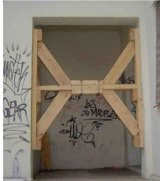
Apeo volante. Acodalado de muros. Autores.
