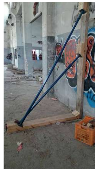
Apeo Inclinado metálico en abanico. Autores.
