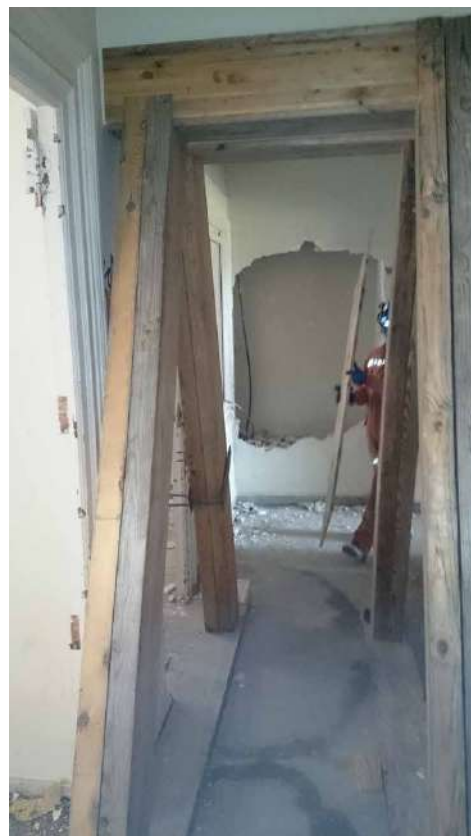
Práctica apeo en viga. (Fuente. UREC del CPBV 2015).
