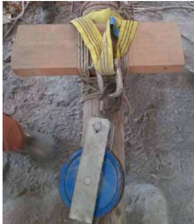
Cabecera mástil. Colocación de polea. (Grupo U.R.E.C., 2017, s.p.)
