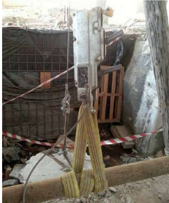
Cabra Ligera. Colocación tráctel. (Grupo U.R.E.C., 2017, s.p.)
