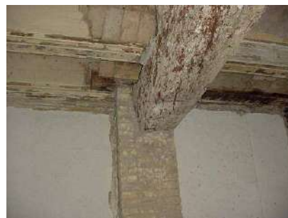
Excentricidad en pilar por apoyo de viga.
