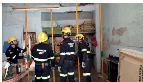
Hundimiento tejado casa unifamiliar sobrecargando forjado y viga lesionada. Se apea de urgencia la viga y forjado con puntales metálicos.
