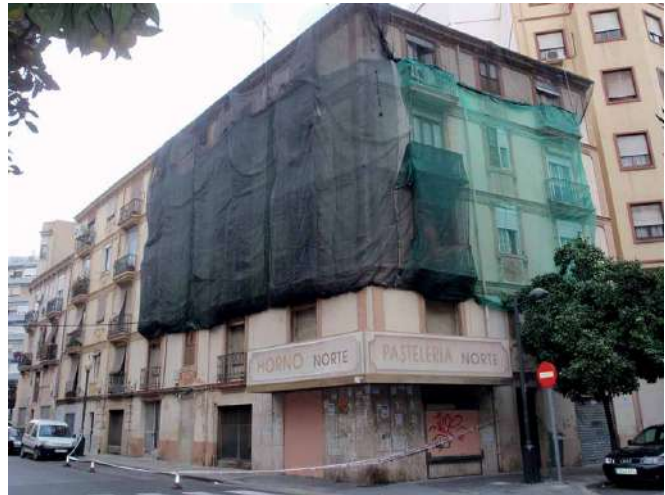
Colocación de red de protección en fachada.
