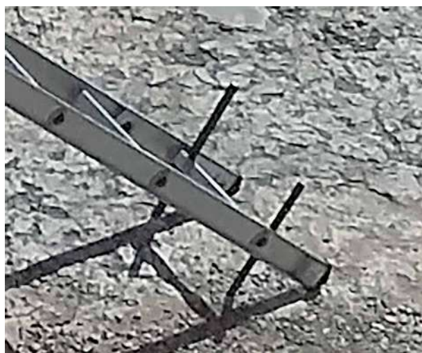
Anclaje inferior escalera. (Grupo U.R.E.C., 2017, s.p.)
