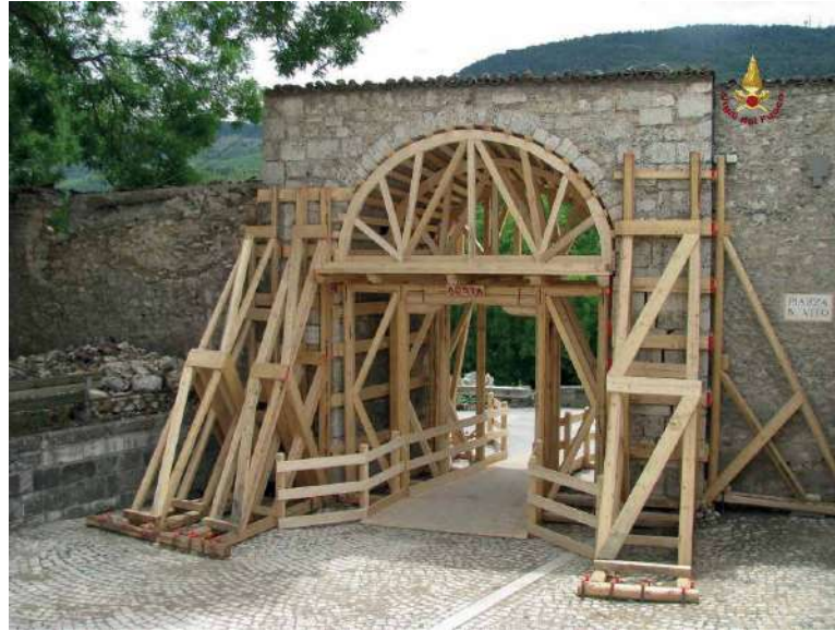
Cimbra realizada por Bomberos Italianos en terremoto de L' Aquila.
