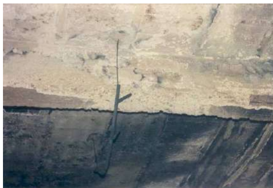
Viga y forjado afectado por incendio.
