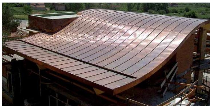
Cubierta de chapa de cobre (Fuente. Cozinc).
