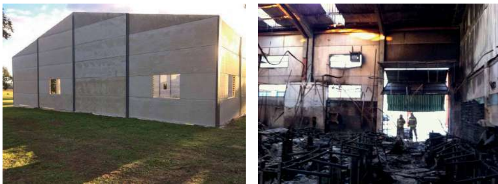
Paneles trabados con la estructura.
