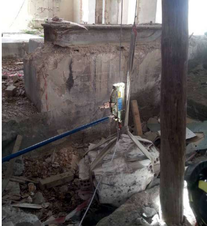
Colocación del tráctel. Elevación de carga. (Grupo U.R.E.C., 2017, s.p.)
