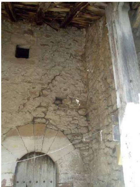
Lesiones de asentamiento de un pilar que soporta arcos.
