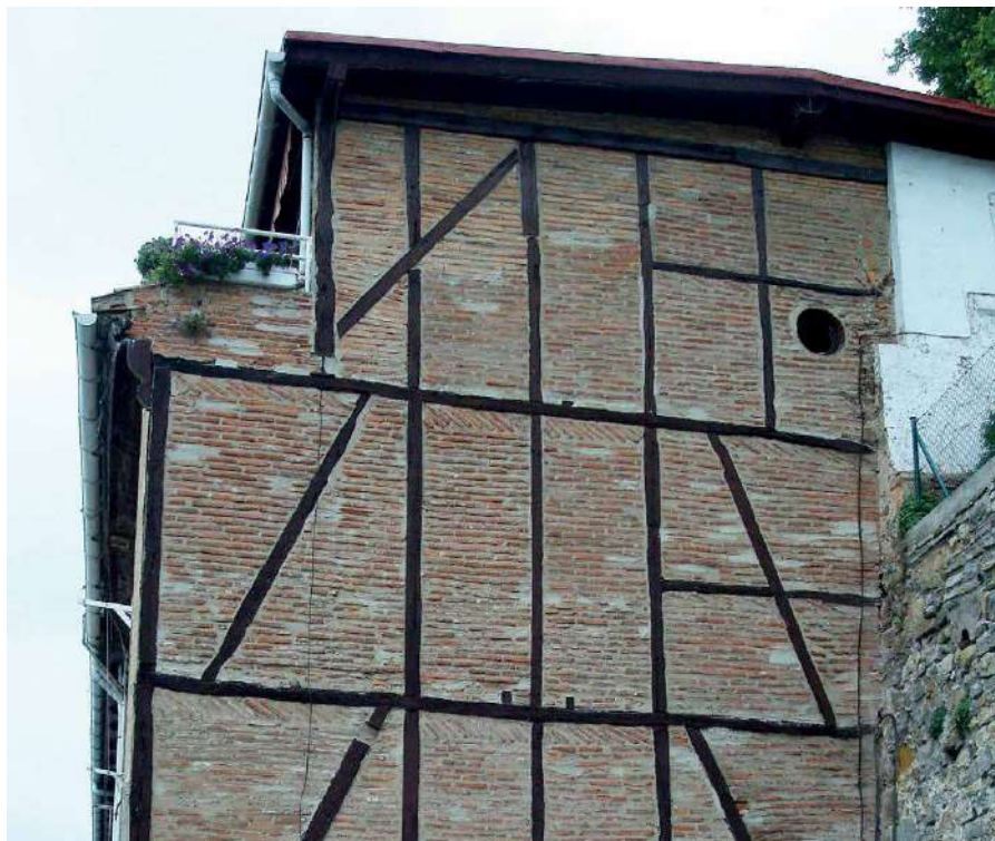
Estructura de entramado de madera.
