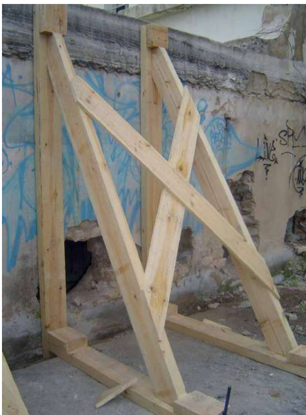
Apeo Inclinado Simple arriostrado. Autores.
