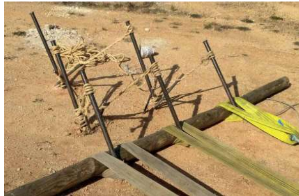
Colocación de estacas. (Grupo U.R.E.C., 2017, s.p.)
