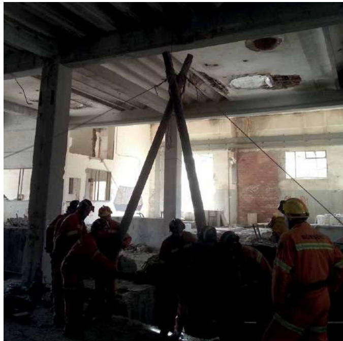
Cabra Ligera. Ejecución de los vientos. (Grupo U.R.E.C., 2017, s.p.)
