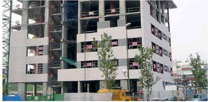
Fachada prefabricada de hormigón. (Fuente. Prehorquisa).
