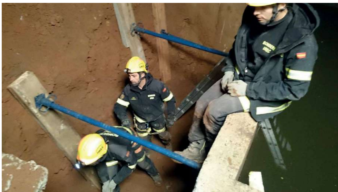
Entibación ligera de urgencia utilizando puntales telescópicos, Rescate de un animal atrapado. (Fuente. UREC. CPBV 2016).
