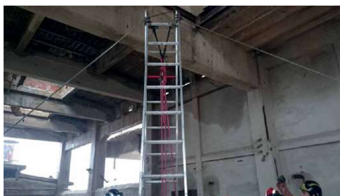
Trípode con escaleras Grupo U.R.E.C 2017
