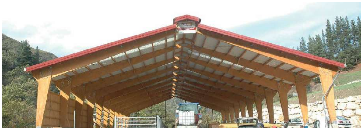
Pórtico de (madera Fuente. Estructuras Zurtek).
