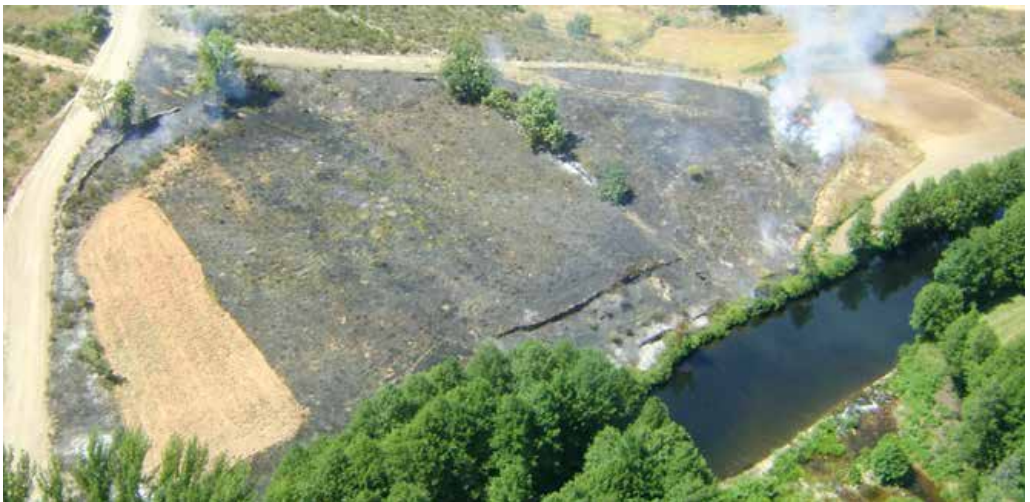
Figura 8. Línea de control integrada por distintos tipos de barreras existentes
