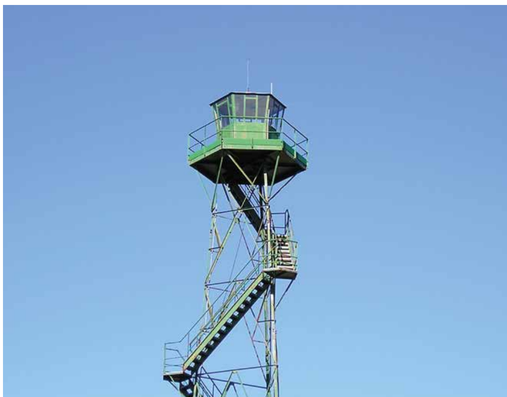
Figura 35. Puesto de vigilancia
