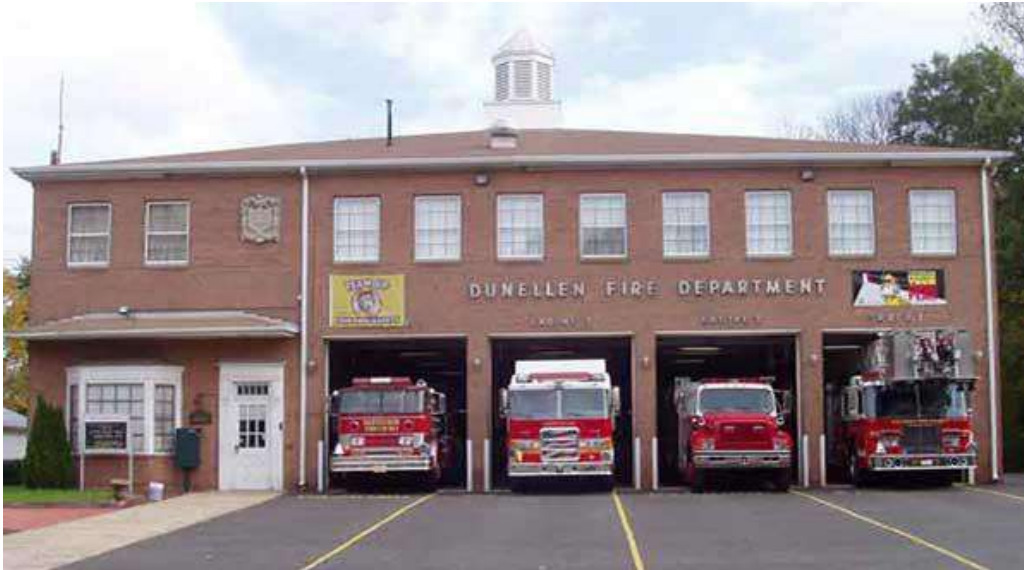
Imagen 25 Sala de maquinas
