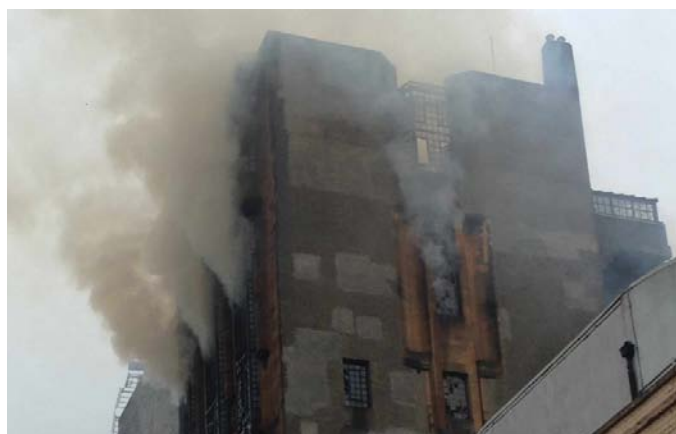
Imagen 168: El acceso a viviendas en altura dificulta las operaciones de extinción.
