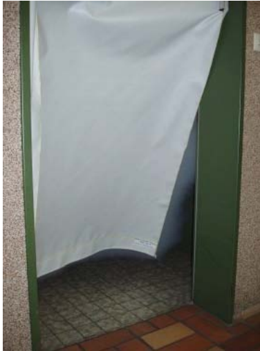
Imagen 173: La cortina de bloqueo de humo succionada hacia el interior indica que el incendio tiene una apertura al exterior y que se ha establecido un flujo de gases unidireccional.
