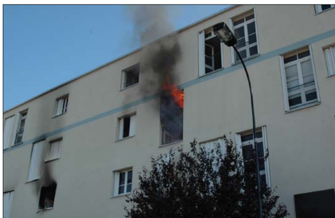
Imagen 18. Incendio en estado ILC
