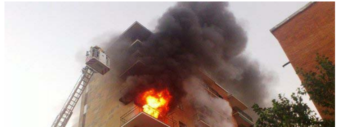
Imagen 175: Incendio con salida de humo en régimen turbulento.
