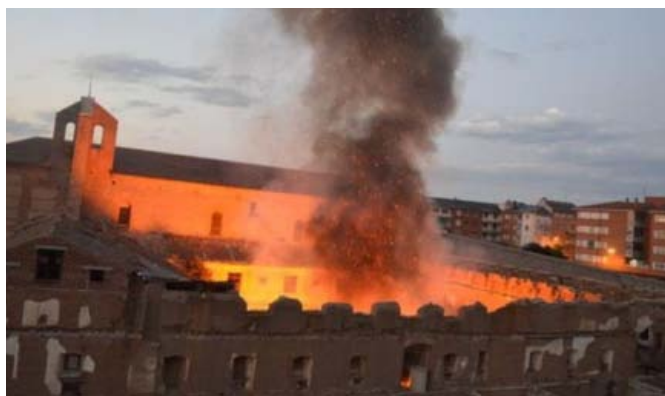
Imagen 166: Incendio en edificio antiguo
