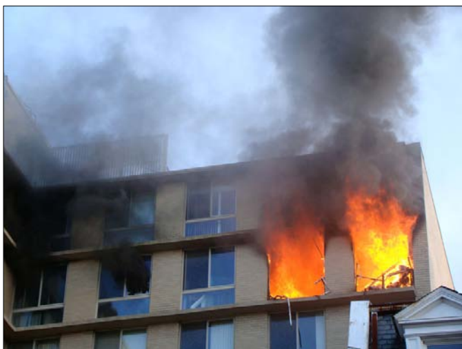
Imagen 17. Incendio en su etapa de pleno desarrollo. En este caso el recinto se encuentra ventilado y se produce una diferenciación clara de los estratos de gases de incendio y aire fresco como puede verse en las ventanas a nivel de incendio a su izquierda.
