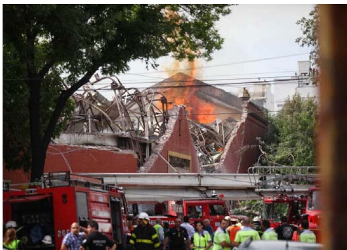
Imagen 164: El colapso de una estructura durante las tareas de extinción de una nave industrial en Barracas (Buenos Aires, Argentina) se llevó la vida de 10 bomberos.
