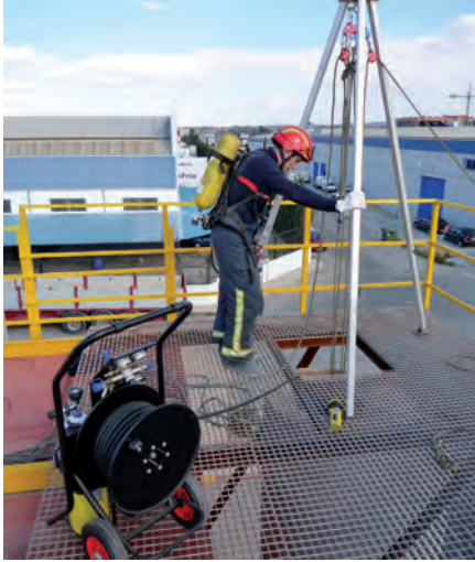
Figura 12. Maniobra de salvamento mediante trípodes y bípode Fuente: Sergio Hernández
