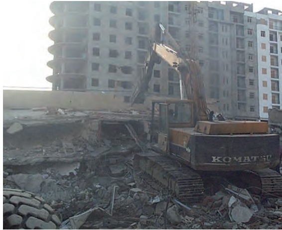
Figura 4. Retirada total de escombros con maquinaria pesada.
