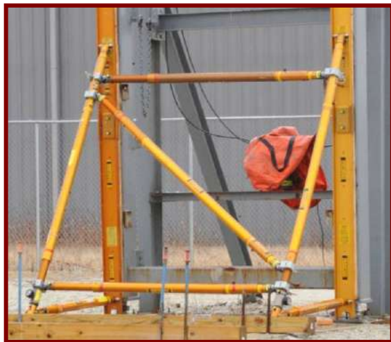
Placa de Base, Ángulo y Conexiones del Fabricante
