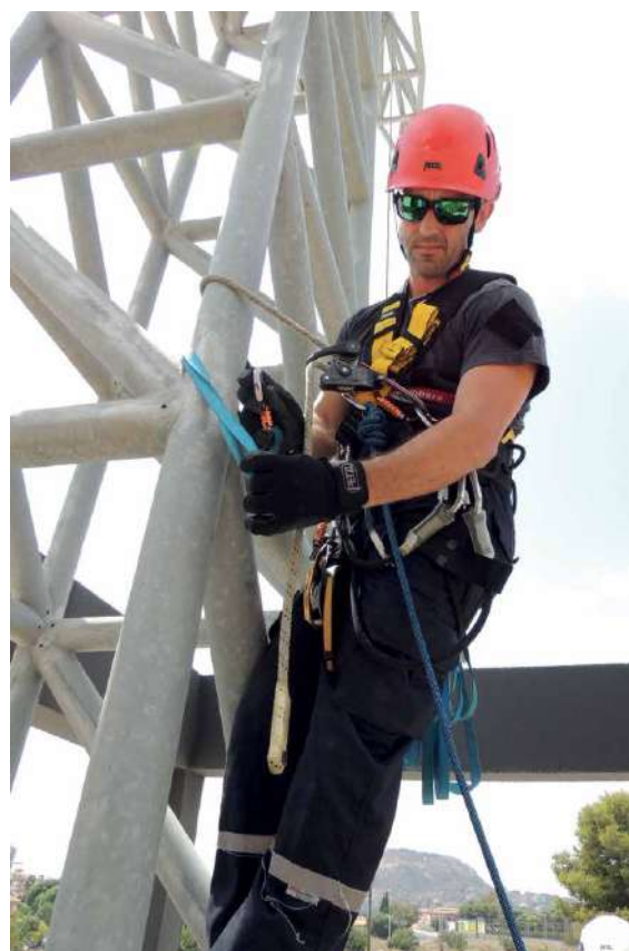
Colocación del primer seguro a menos de 2 metros.
