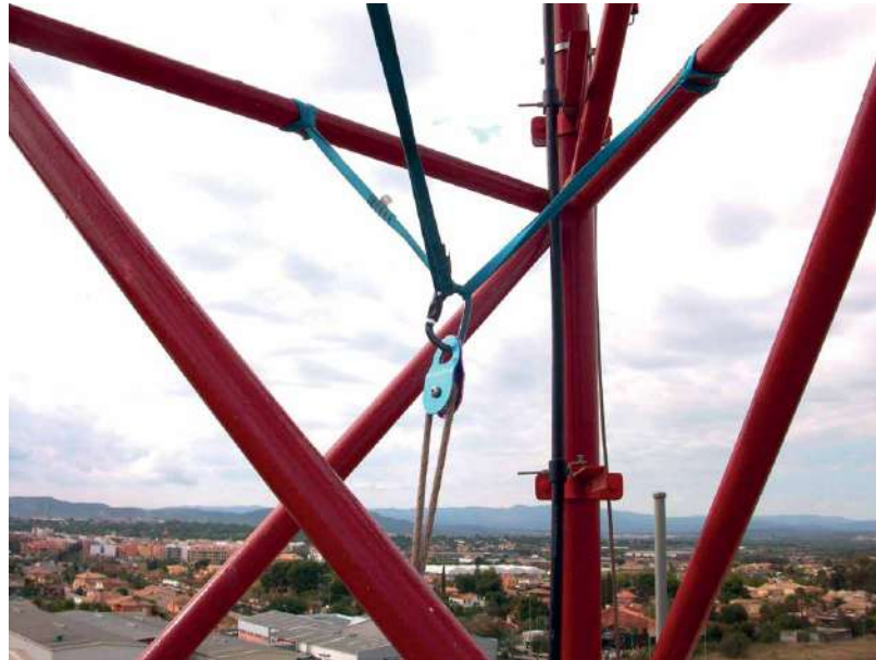
Ejemplo de cabecera ejecutada con anillos de cinta certificada.
