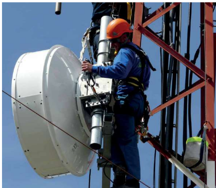
Instalación de antenas de telecomunicaciones.
