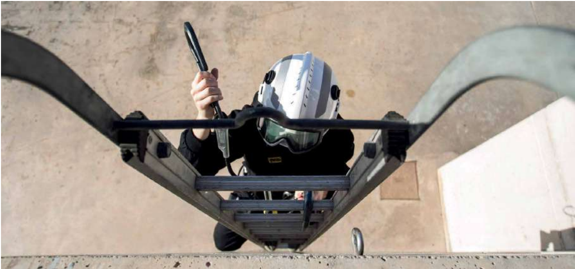
Sistema anticaídas con elemento de amarre doble, absorbedor y conectores tipo gancho HMS.
