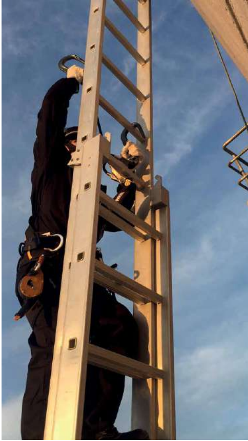
Progresión segura con sistema anticaídas (ganchos MGO + absorbedor).
