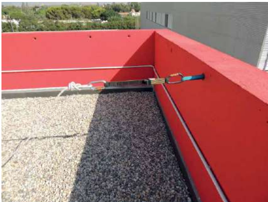
Detalle de los anclajes con absorbedor y elemento de tensado.
