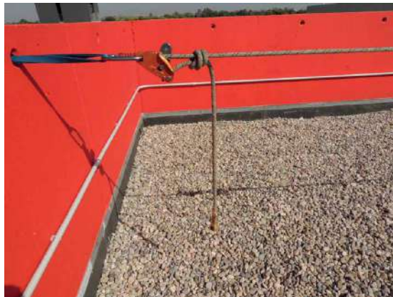
Detalle de los anclajes con absorbedor y elemento de tensado.
