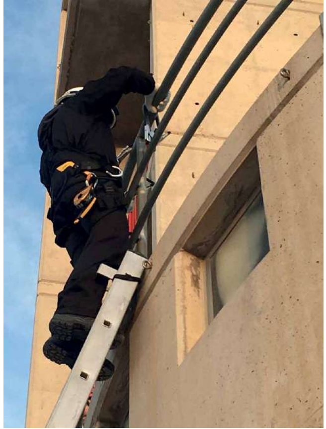
Apoyo en escala manteniendo 3 puntos de apoyo.
