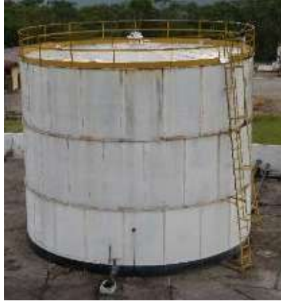
Figura 91. Vista general de tanque pernado intervenido
