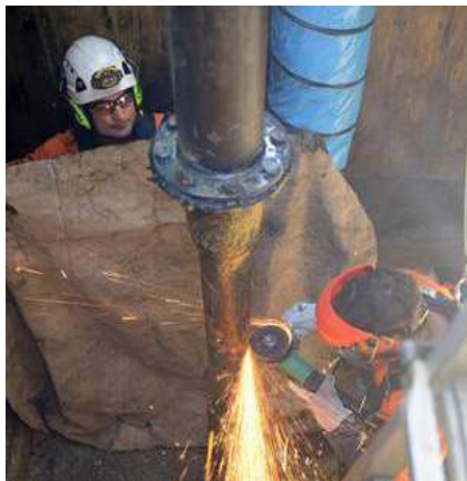
Figura 56. Trabajo en espacio confinado al cual se le inyecta aire cuando cortan la tubería vieja de un pozo de petróleo en preparación para tapar el pozo en Nueva Zelanda
