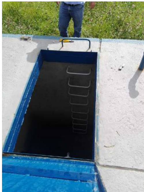
Figura 89. Entrada búnker subterráneo transporte de gas
