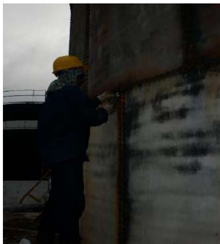
Figura 95. Retiro de lámina tanque
