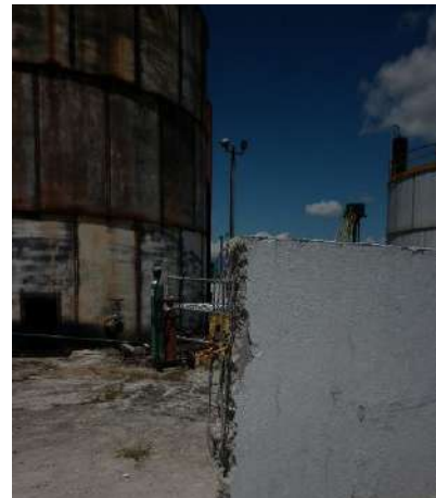
Figura 96. Tanque con lámina retirada
