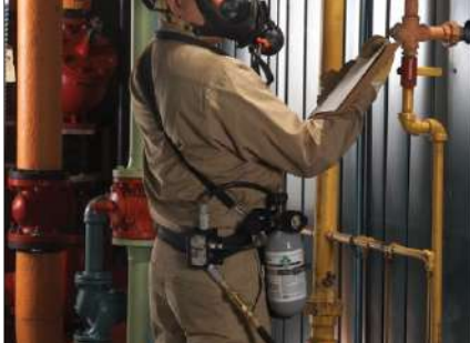
Figura 76. Respirador de línea de aire y cilindro de escape
