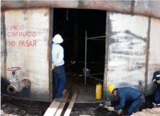
Figura 97. Ingreso al tanque con lámina retirada
