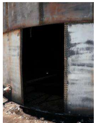
Figura 96. Tanque con lámina retirada
