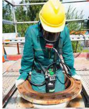
Figura 77. Respirador de línea de aire y cilindro de escape
