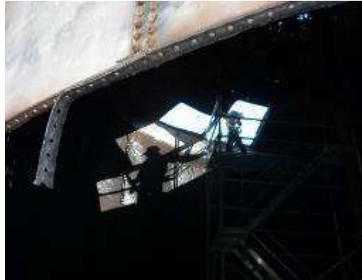
Figura 98. Trabajos dentro del tanque
