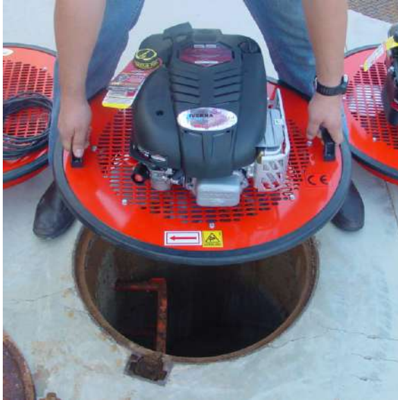
Figura 57. Equipo autónomo extractor de olores sin necesidad de generadores, especial para la ventilación de alcantarillas
