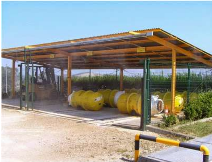
Almacenamiento de depósitos móviles en edificio abierto Fuente: www.lanuevapreencionderiesgoslaborales.blogspot.com
