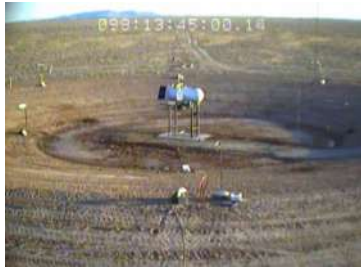
Tambor de 1 Tn de cloro antes de la fuga
